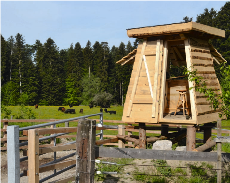
Die 180 x 180 cm grosse Jagdkanzel steht etwa 1,5 m über dem Boden. Der Raum ist etwa 200 cm hoch, damit der Schütze darin aufrecht stehen kann. Die Schussposition befindet sich etwa 3 m über dem Boden. Ein höhenverstellbarer Barhocker dient als Sitzgelegenheit.
